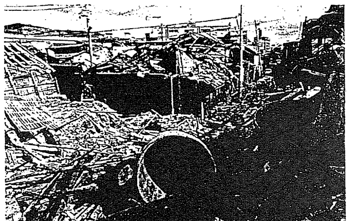
阪神大震災で壊滅的被害を受けた酒蔵地帯。現在は町のたすまいが一変している。神戸市東灘区御影塚町(一九九五年一月十七日撮影)
