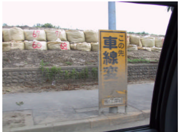
8 / 1 堤防決壊の現場
