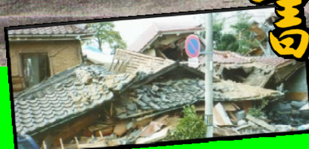
○阪神淡路大震災で倒壊した長濱家
